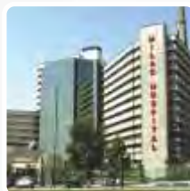
بیمارستان میلاد سیستم BMS
