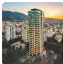
برج مهرآفرین کنترل تهویه مطبوع
