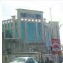
ساختمان مترو تهران کنترل تهویه مطبوع
