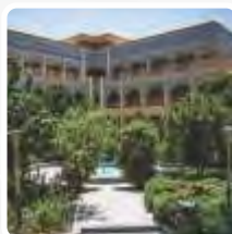
جامعه الزهرا قم سیستم BMS
