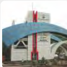
نیروگاه سیاه بیشه کنترل تهویه مطبوع
